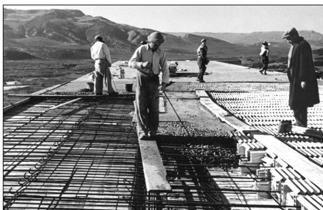
Figg. 16 e 17 – Borgo Irsina (MT) – Scuola: realizzazione del solaio di tipo misto gettato in opera e con camera d'aria (1952) e Casa Cantoniera del consorzio di Bonifica: realizzazione di un solaio di tipo SAP (1954)– Archivio Buonsanti
