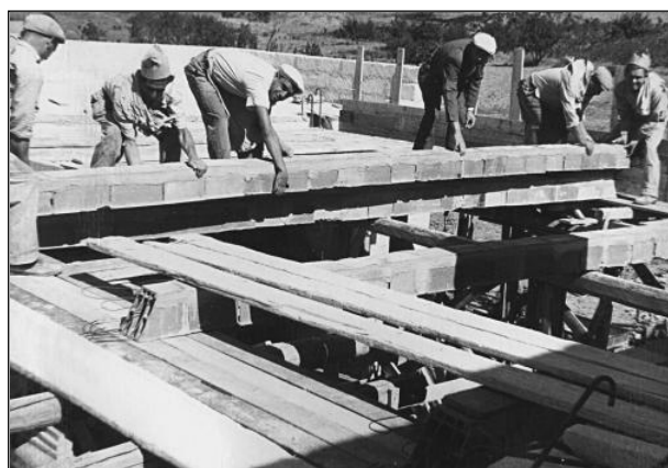
Figg. 16 e 17 – Borgo Irsina (MT) – Scuola: realizzazione del solaio di tipo misto gettato in opera e con camera d'aria (1952) e Casa Cantoniera del consorzio di Bonifica: realizzazione di un solaio di tipo SAP (1954)– Archivio Buonsanti
